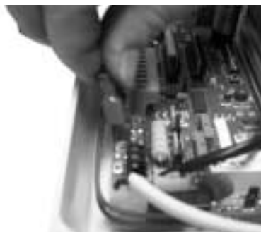
Entfernung der Motorkabel von dem KS SUPER
