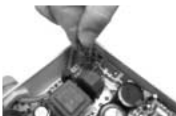
Motorkabel auf Inverter
